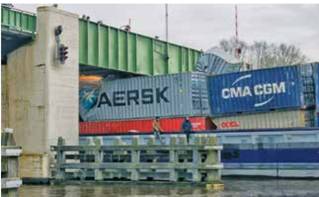
Sorry collega/brugwachter, dat ging niet helemaal goed (helemaal niet goed). Plezierjachten, maar ook beroepsschepen kunnen uit de bocht of aan de grond lopen, de stuurhut eraf varen tegen een brug, in botsing komen met remmingswerken, sluisdeuren of met elkaar.
